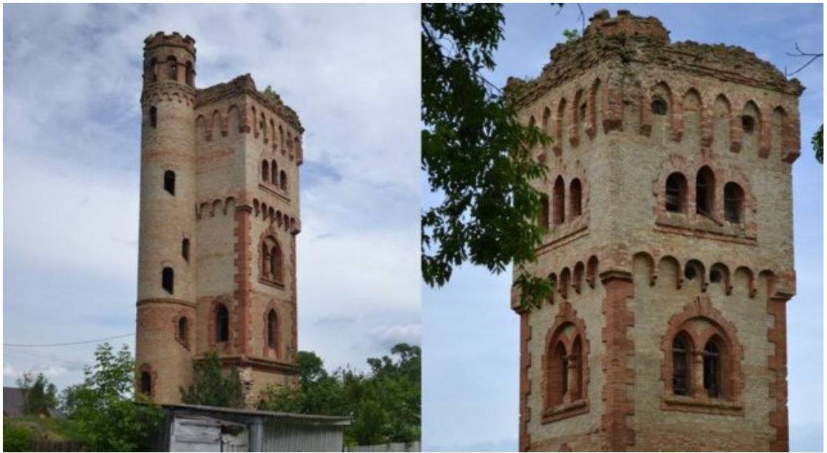
Рис. 2. 7. Водонапірна вежа у Зірному.
